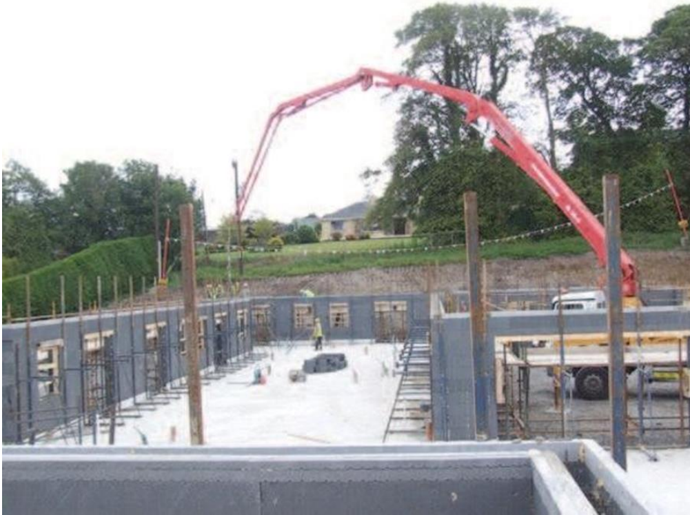
Typical Concrete Pour photo
