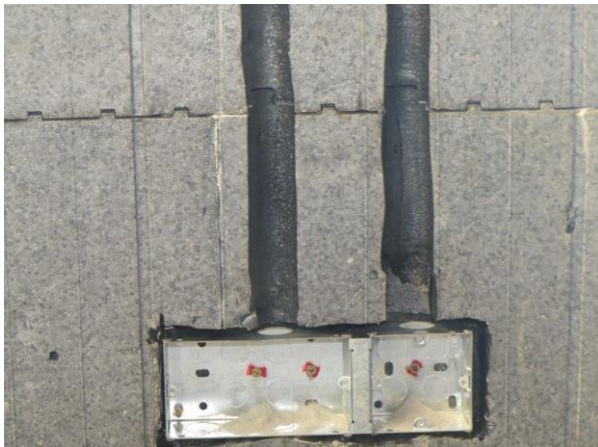
Hot Knife Conduit Chasing
